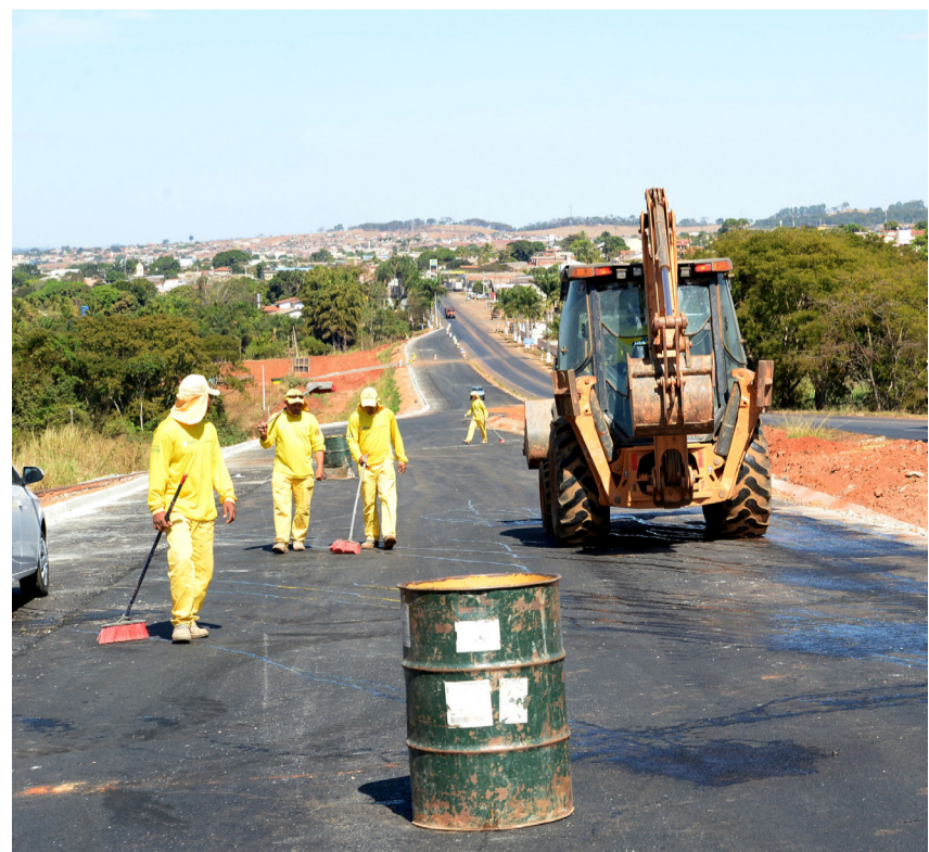
Foram retomadas as obras de duplicação dos 100 quilômetros da GO-080 no trecho entre Nerópolis e a BR-153
